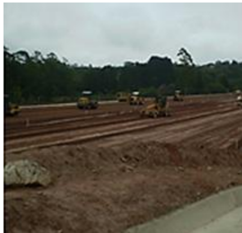
Figura 10 – Regularização do sub-leito.
