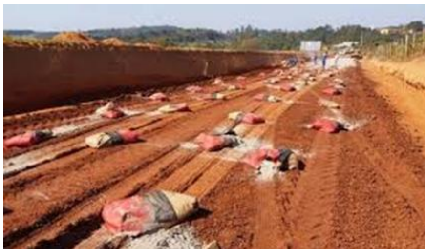
Figura 6 – Sacos de cimento sobre a pista (terra).
