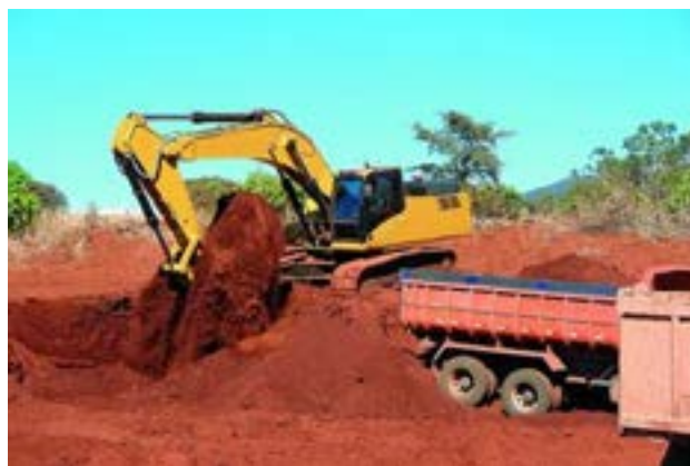
Figura 12 – Escavação de material de jazida.
