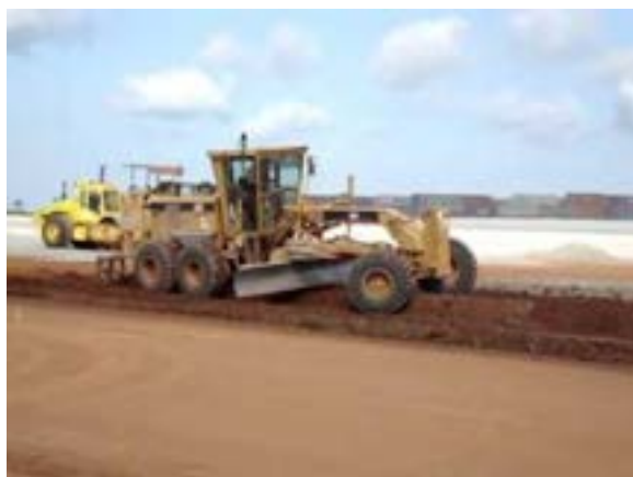
Figura 14 – Mistura de materiais por meio de motoniveladora
