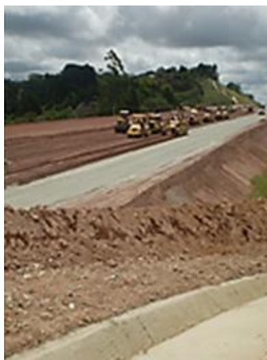
Figura 11 – Reforço do sub-leito.
