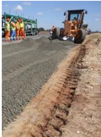
Figura 7 – Espalhamento da camada de BGTC.
