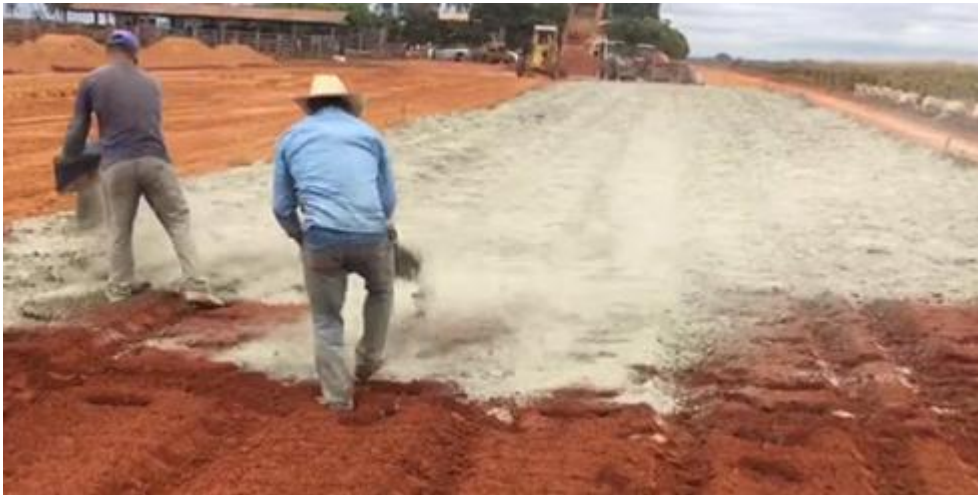
Fonte: Alexandre Zadra, 2020. Figura 9 – Processo de realização de CCR.
