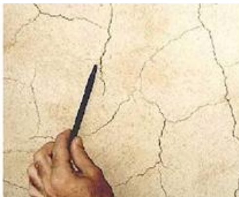
Fonte: Internet, Instituto Brasileiro de Desenvolvimento da Arquitetura, Fórum da Construção. Figura 4 – Retração plástica.
