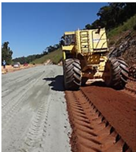
Figura 11 – Reforço do sub-leito.
