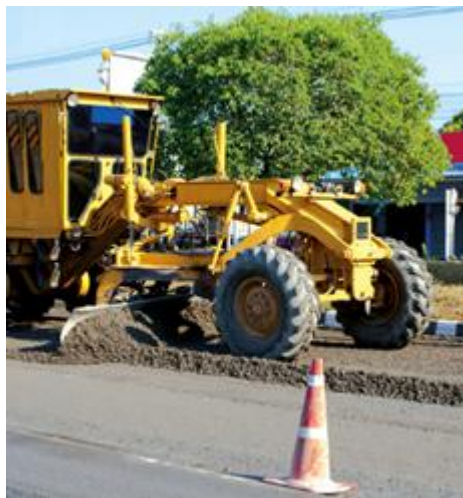
Fonte: Ministerio de Vivienda y Urbanismo, 2018. Figura 8 – Processo de realização de CCR.
